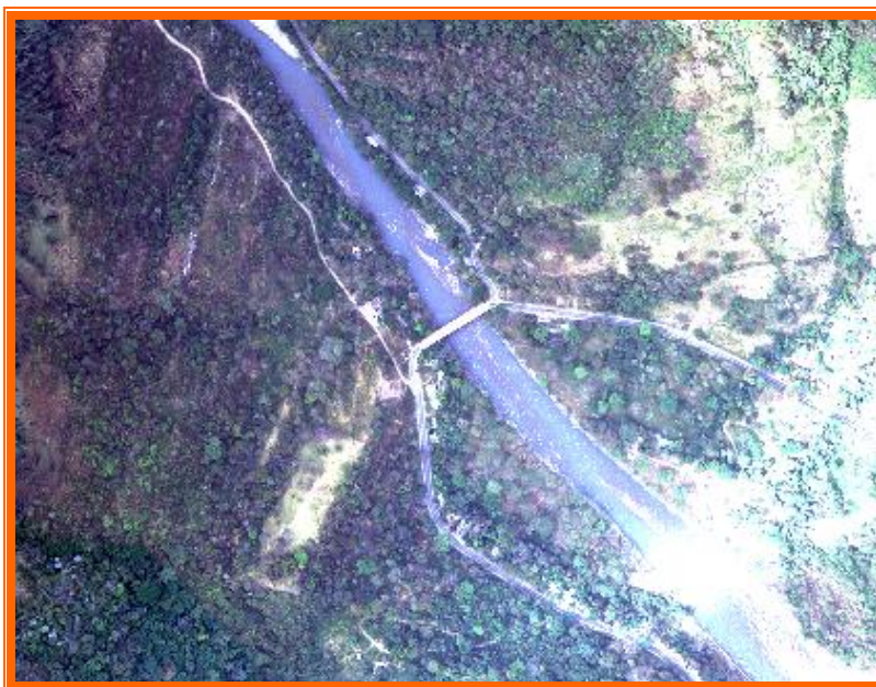
FIGURA 3.6 - Vía Yopal – La Chaparrera sobre río Cravo Sur, Estación Puente Yopal
