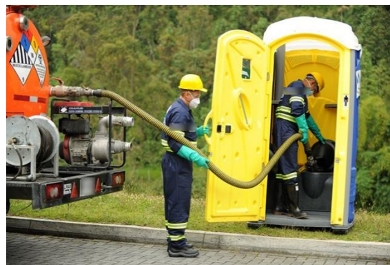
Figura 10-4 Manejo de agua residual doméstica durante actividades constructivas
