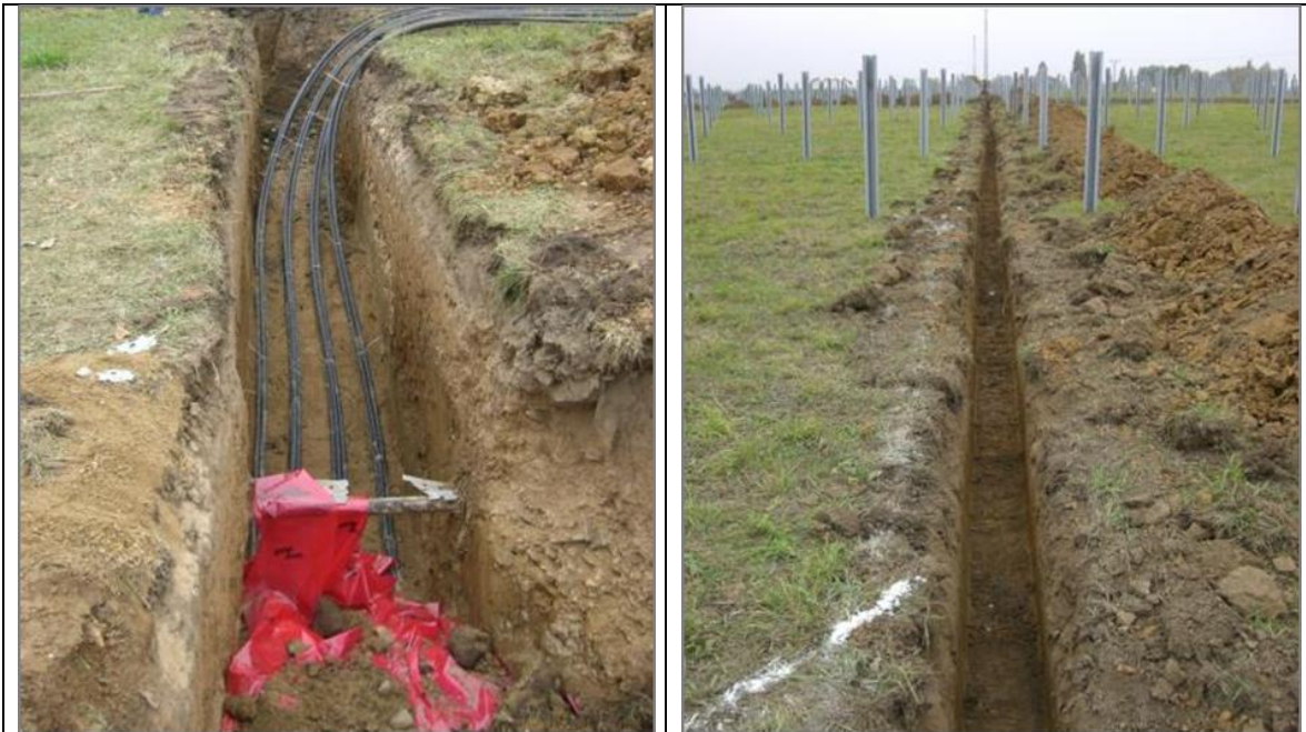
Figura 3-7 Ejemplo de zanjas en construcción
