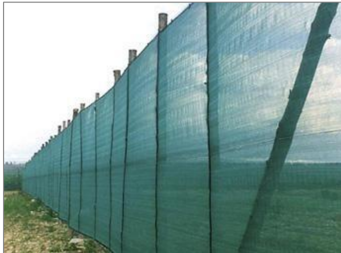
Figura 3-39 Ejemplo de cerramiento provisional para áreas de trabajo
