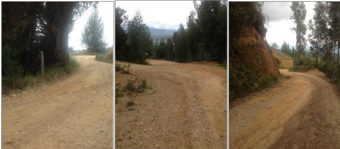
Figura 3-45 Punto a acondicionar
