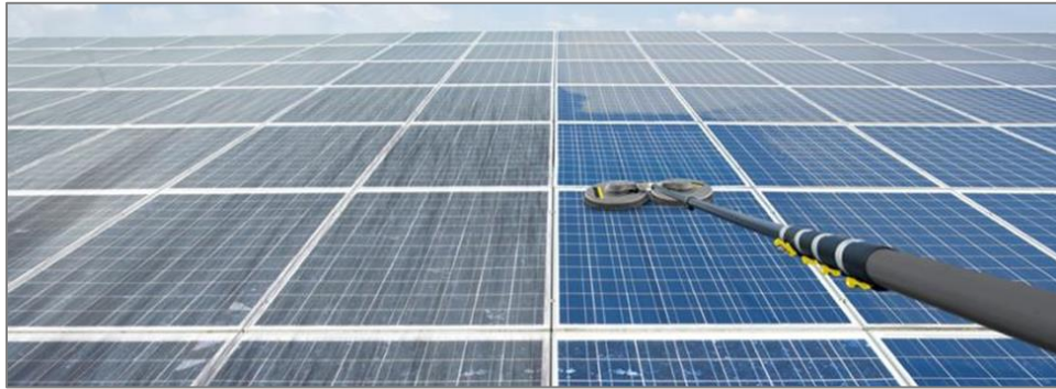
Figura 3-13 Sistema de limpieza de módulos
