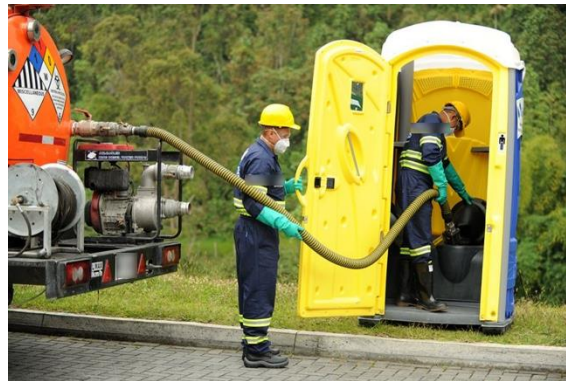
Figura 7-1 Manejo de agua residual doméstica durante actividades constructivas
