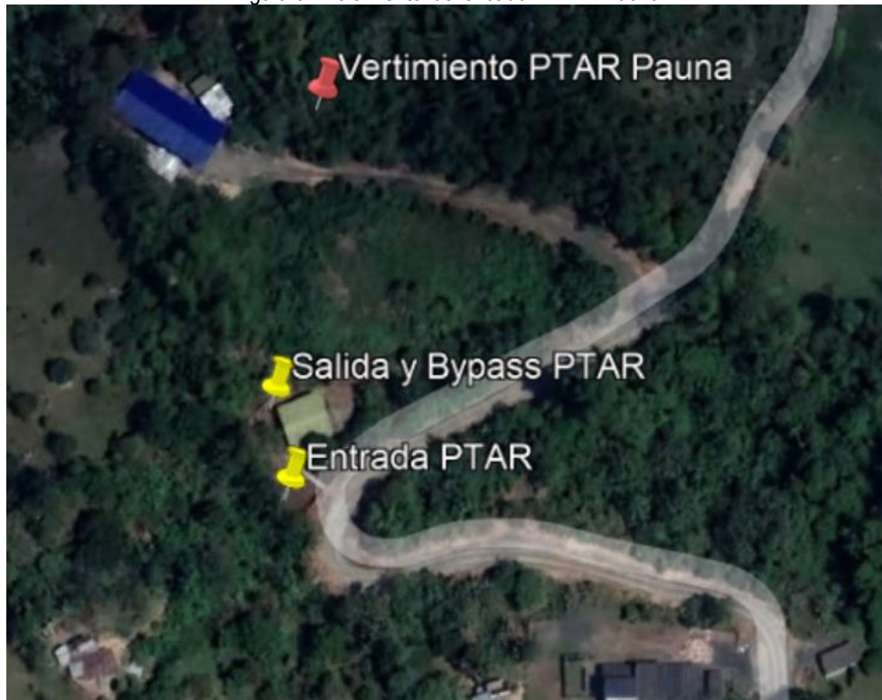
Figura 3 . Vertimiento identificado PTAR - Pauna.
