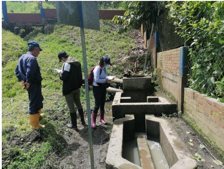
Figura 7. Estado del cribado al momento de la visita
