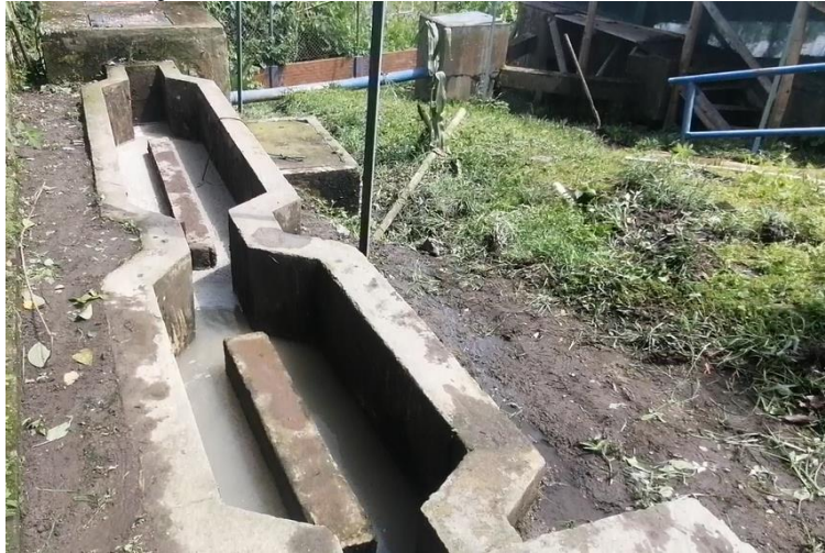
Figura 9. Estado desarenador al momento de la visita
