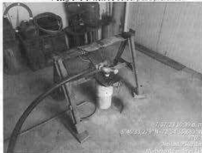
Fotografía 3. Estado actual pozo profundo.
