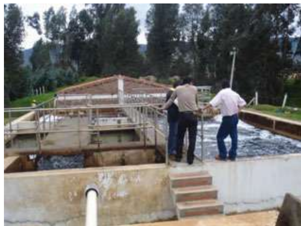
Foto 16. PTAR, vereda Chámeza municipio Nobsa
