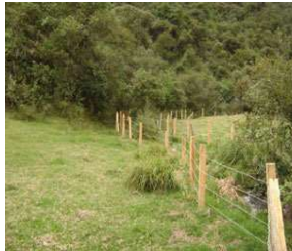
Foto 25. Recuperación de la ronda Venta quebradas Toibita y el Totumo.
