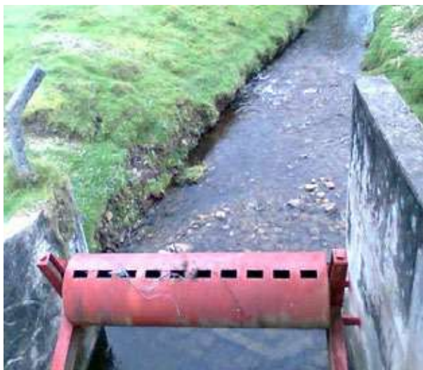
Fotos 33 y 34. Limpieza de rejillas y mantenimiento a compuertas de canal de desviación Río Olarte. Agosto de 2009
