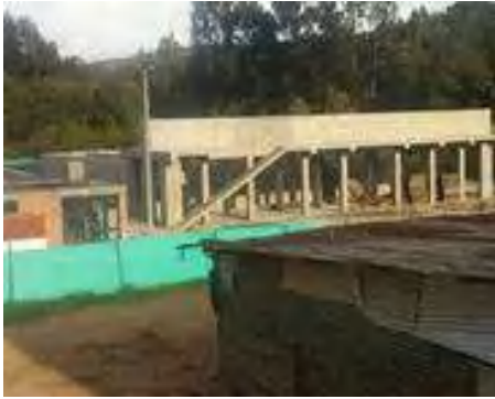
Fotos 16-17. Avance construcción modulo 2 CNV 2099-157
