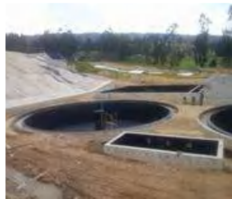
Fotos 18-19. Avance construcción modulo 3 CNV 2099-156
