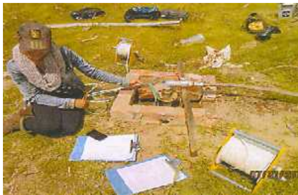
Foto 24. Prueba de bombeo
