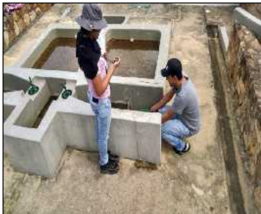
Foto 31 Medición de caudal obra control caudal abrevadero
