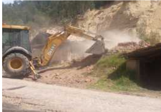
Foto 22. Actividad demolición hornos
