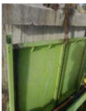
Estado compuerta tipo guillotina
