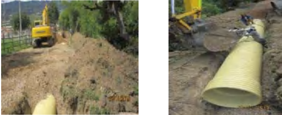
Figura 55. Construcción interceptor
