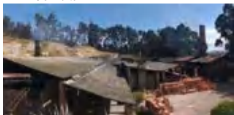
Figura 39. Ladrillera Bellavista, Cómbita
