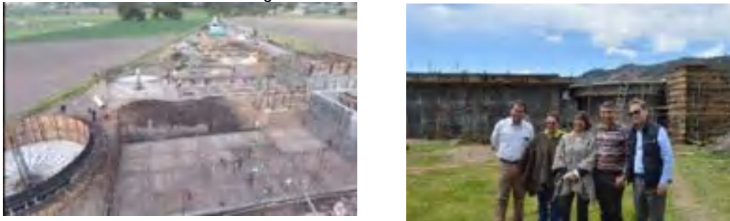
Figura 56 Construcción PTAR Samacá
