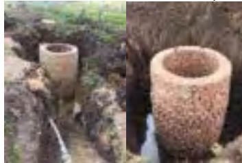
Figura 54 Construcción Pozos de inspección
