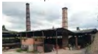
Figura 41. Ladrillera El Zipa, Paipa
