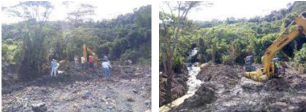
Figura 88. Vista del área de cultivo afectada por el desbordamiento del cauce de la quebrada El Barro.
