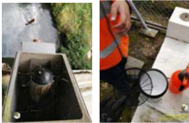
Figura 70 limpieza de sensores Fuente: Corpoboyacá
